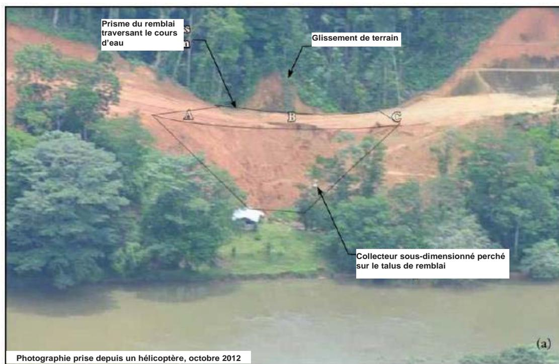
2.34. Là encore, le passage de cours d'eau a été bouché au moyen de matériau de remblai pour faire passer la route. Selon MM. Hagans et Weaver, cette image montre que l'emplacement «est en proie à une déformation et à une érosion importantes du talus de remblai situé en aval, très peu de temps après la construction»<sup>126</sup>. La quantité de remblai qui obstrue le cours d'eau est beaucoup plus importante que dans les deux exemples précédents, car son volume atteint quelque
