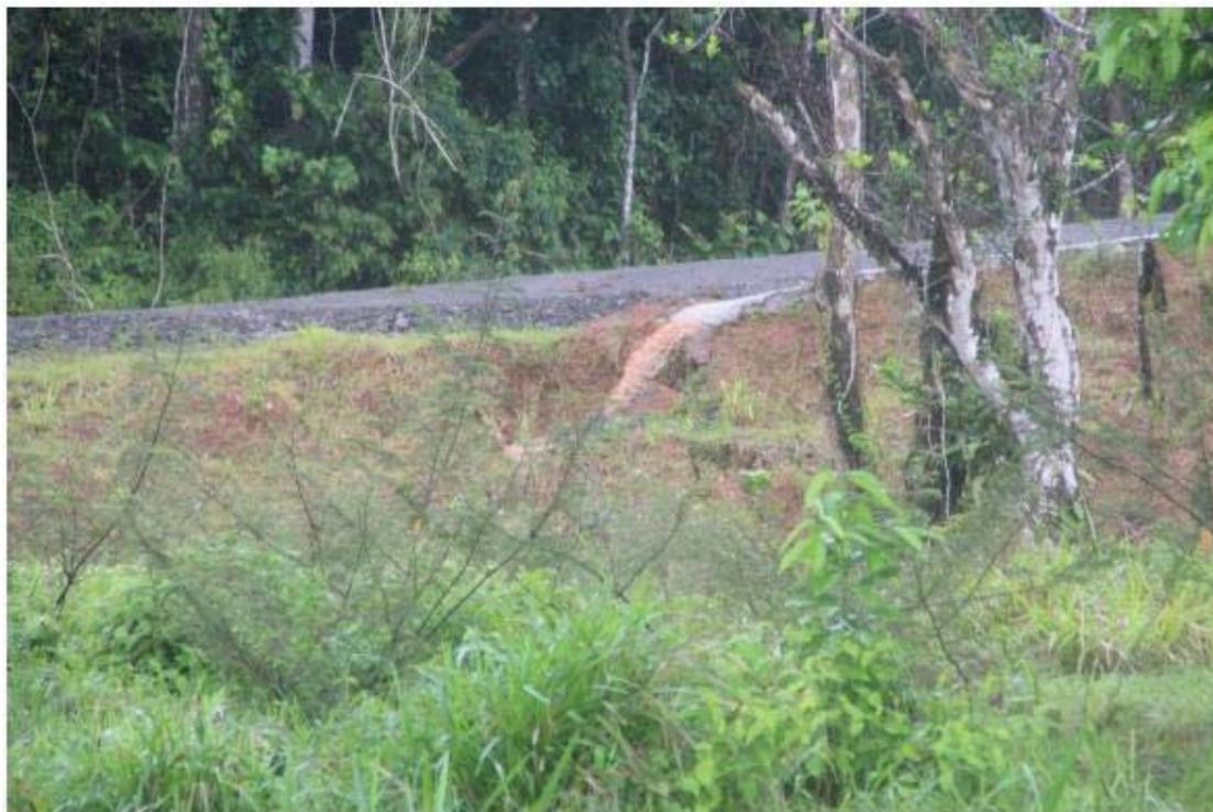
**Figure 3.4. : Photographie prise en mai 2014 et montrant l'érosion résultant de la déviation des eaux de l'ouvrage de drainage vers le remblai**
