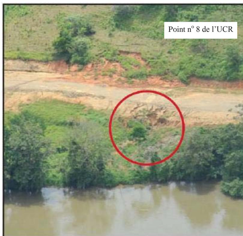
**Figure 2.38. : Vue aérienne du point n° 9 de l'UCR : ravinement d'un remblai**
