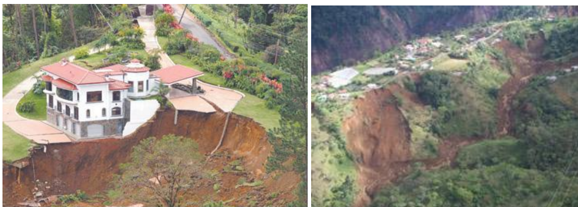
Figure 10. Photographies des glissements de terrain survenus en janvier 2009, montrant les types de dégâts provoqués par le séisme de Cinchona (pour son emplacement, voir figure 9).
