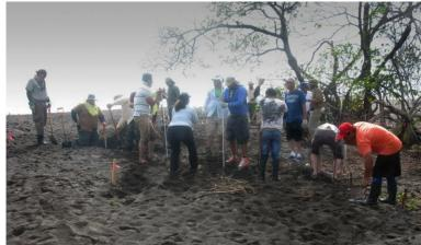
Figure 15 : Sondage du sable à l'aide de barres de fer de deux mètres de long.
