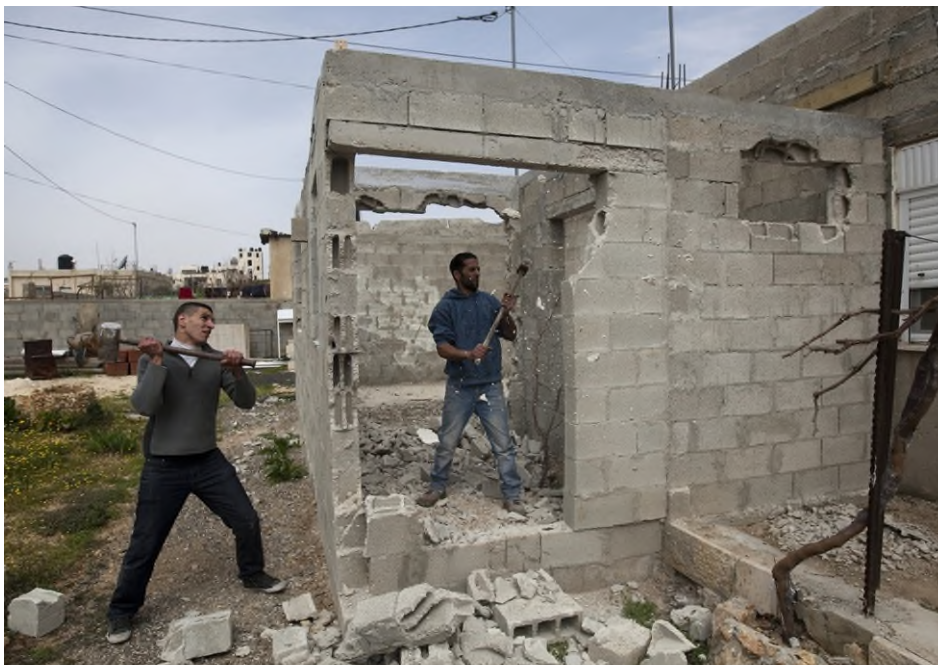
Figure 2.6 : Le Palestinien Motasem Farrah (au centre) démolit sa maison, aidé par un ami, dans un quartier arabe de Jérusalem-Est, 12 mars 2012. Israël explique souvent aux Palestiniens qui érigent une construction sans permis qu'ils doivent démolir eux-mêmes la maison, sans quoi Israël leur facturera le coût de la démolition. 159
