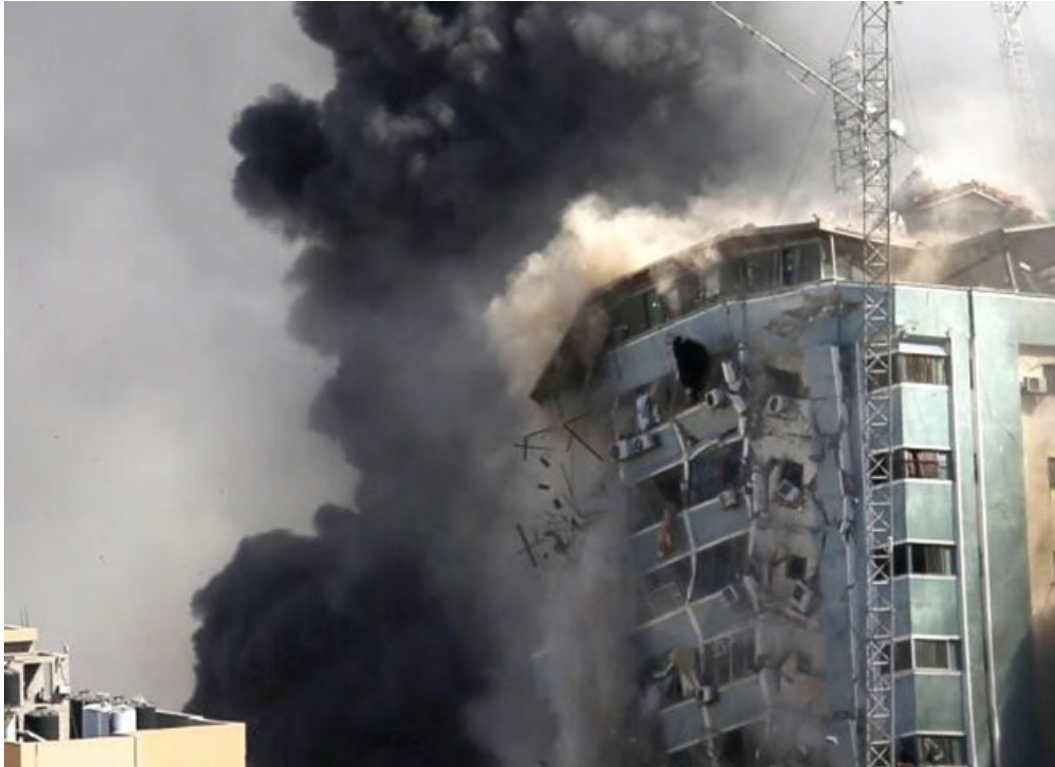
Figure 2.38 : Le bâtiment abritant les bureaux de l'Associated Press et d'autres médias dans la ville de Gaza s'effondre après avoir été frappé par un bombardement israélien, 15 mai 2021 711
